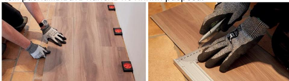
В местах, где сложно соединить планки ENNFACE SPC FLOORING при помощи подбивочного блока (например, у стены), можно использовать специальную скобу и молоток для соединения планок.
