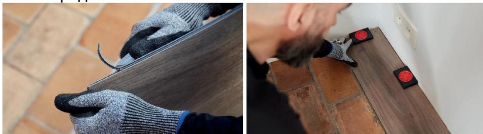
При укладке последней планки в ряду ее следует измерить и обеспечить необходимый температурный зазор. Не укладывайте панель слишком плотно к стене. Отрежьте помеченный участок и установите концевую панель таким же образом, как и предыдущие панели. Обрезая панель строительным ножом, убедитесь, что лезвие
